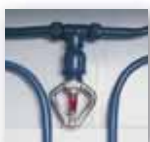
1 Un' ulteriore sicurezza data da uno sprinkler che in caso d'incendio libera il liquido dello scambiatore.
